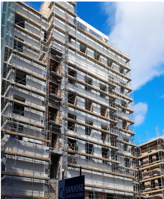
Figura 3 y 4. Construcción del Hotel H10 de Rafael Moneo
