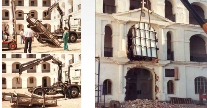
Figura 2. Detalle de las obras de rehabilitación del Campus de Leganés.
