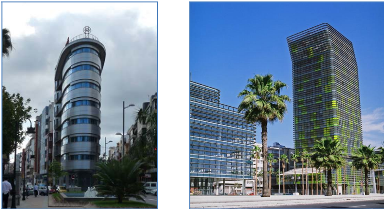
Figura 3. Edificio Ovalum (izquierda) y Plaza y Torre Woerman (derecha) en Las Palmas de Gran Canaria
