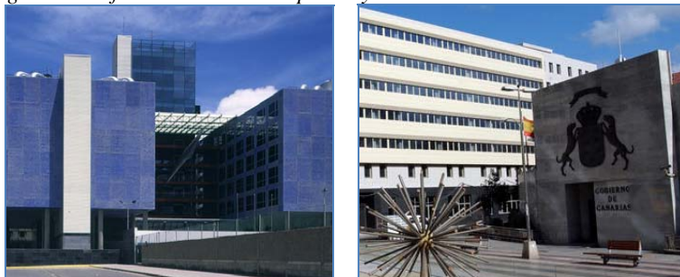
Figura 2. Edificios de Usos Múltiples II y III en Las Palmas de Gran Canaria
