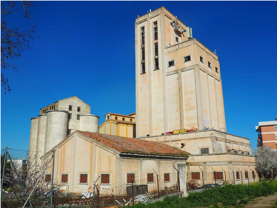
Figura 1. Complejo de silos en Ciudad Real (España)
