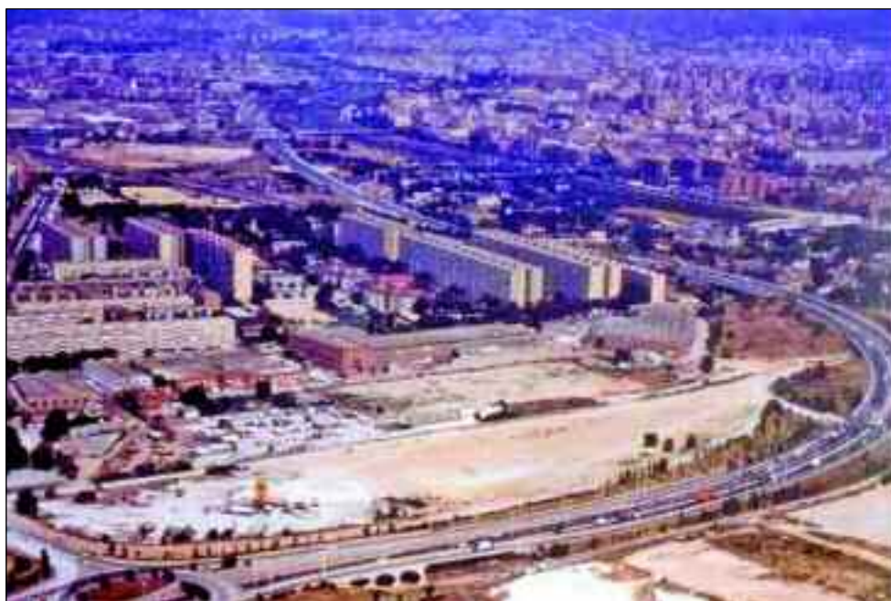
Figura 1: Imagen general de La Mina.
