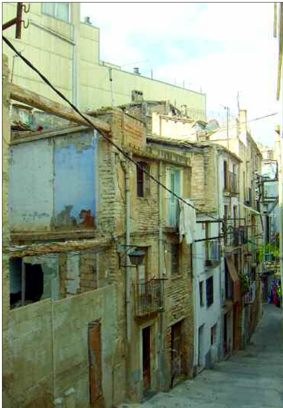
Figura 2: Zona degradada que ocupa el solar del antiguo convento de San Blas.
