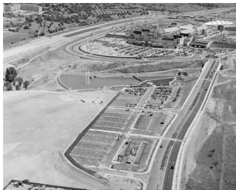
Figura 3. Fase de ampliación Madrid-Xanadú
