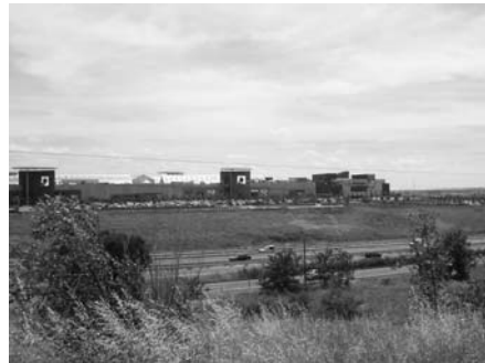
Figura 7. Vista exterior zona de comercio
