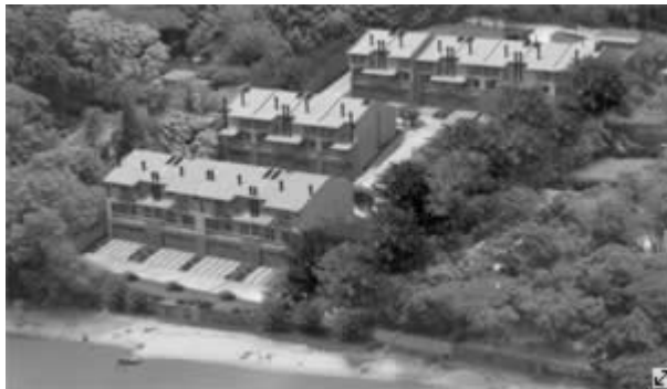
Figura 3. Vista general del condominio Pier39
