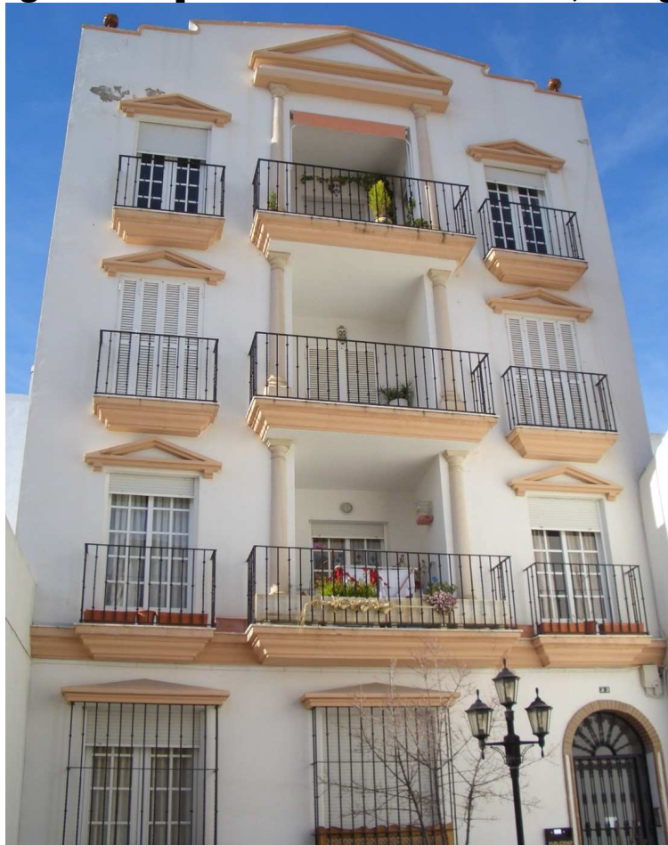
Figura 4. Arquitectura trivial en Ronda, Málaga
