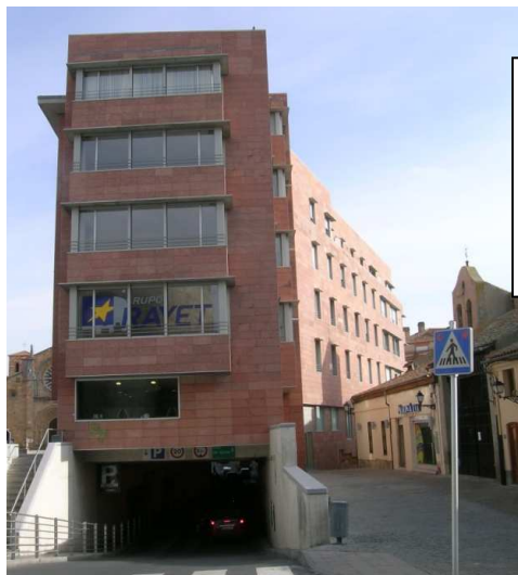
Figuras 3 y 4. Edificio de situado en la Plaza del Mercado Grande en Ávila, de Rafael Moneo
