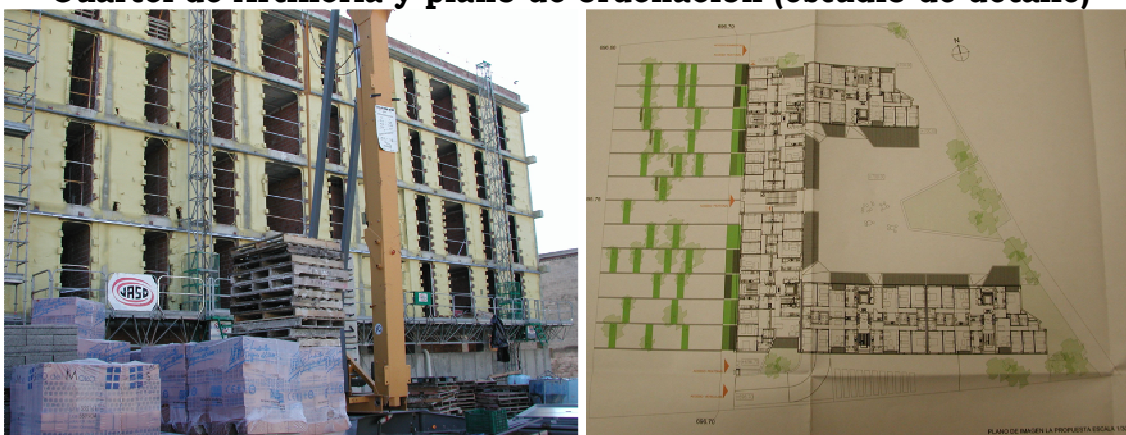
Figura 5. Bloque de viviendas VPP que se construye en terrenos del Cuartel de Artillería y plano de ordenación (estudio de detalle)
