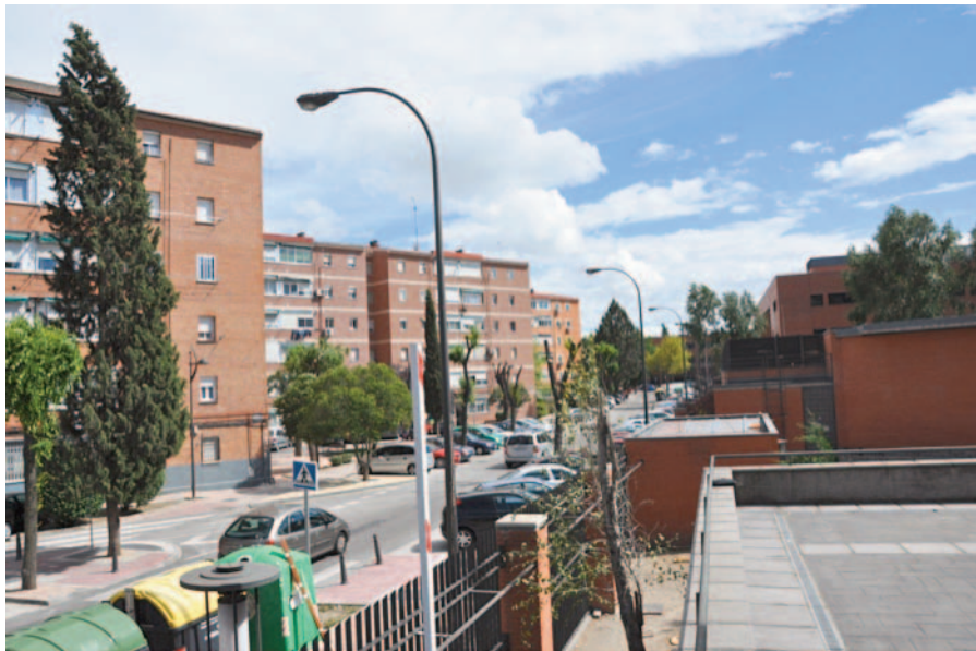
Figura 5. Zona de confluencia entre Las Margaritas y campus universitario (Uc3M), 2014
