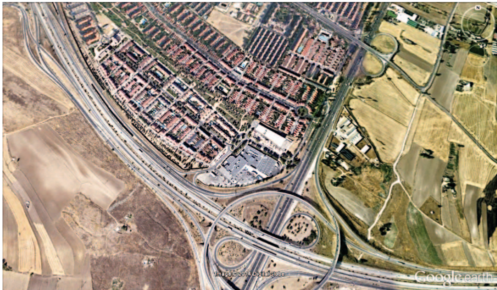
Figura 2. Actuaciones en Arroyo Culebro
