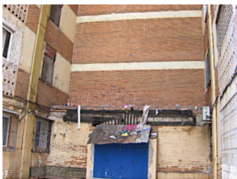
Figura 5. Patio interior de bloques
