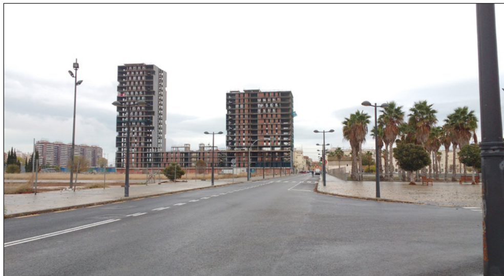
FIGURA 3. Edificios sin terminar en Sociópolis. Imagen propia. 2017.
