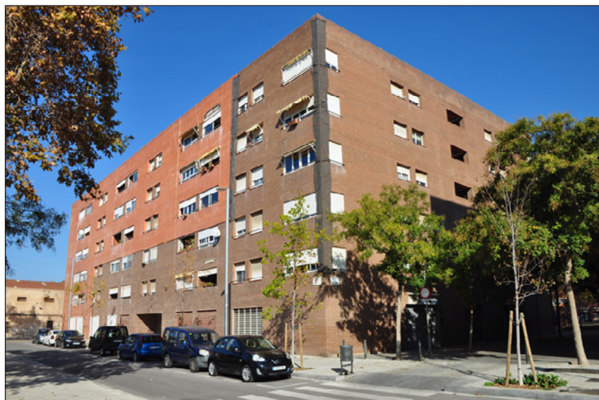
FIGURA 11. Deterioro de edificios modernos
