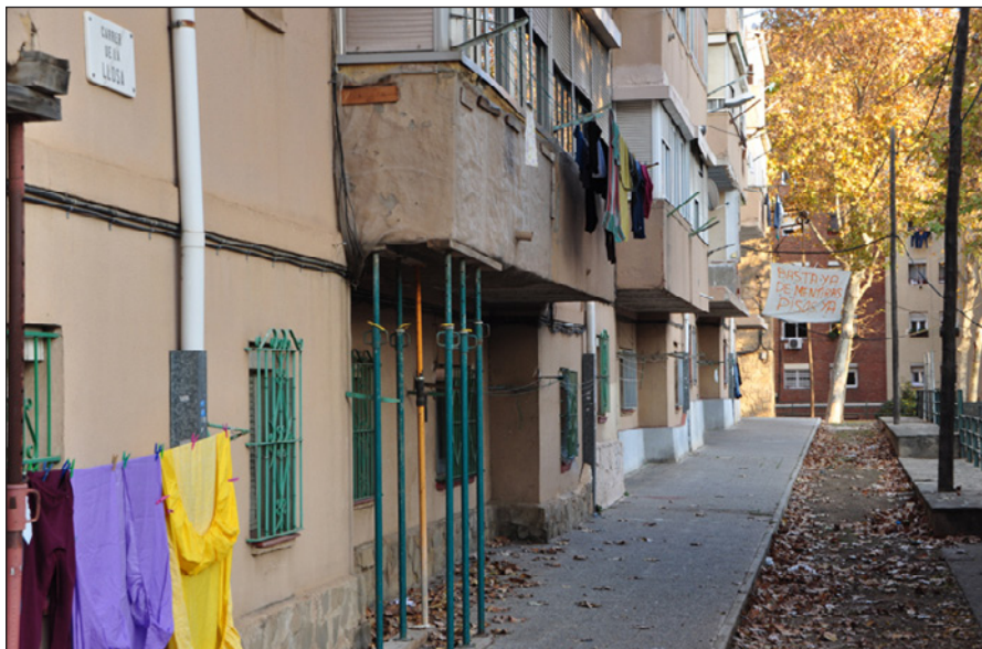
FIGURA 4. Viviendas pendientes de demolición
