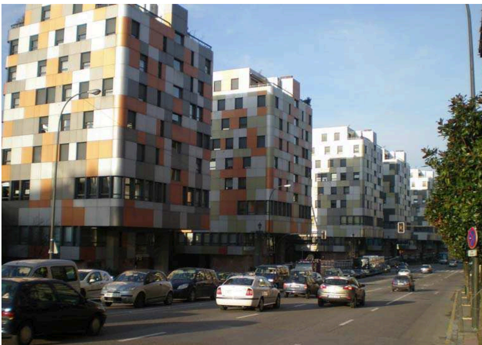
Fig. 1.8. Frente edificado entre la ronda interior de Oviedo y la losa que cubre el espacio ferroviario.
