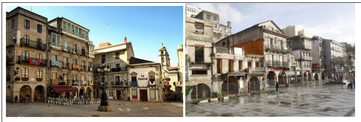
Figura 7. Praza da Constitución en el Casco Vello (izquierda) y el antiguo puerto de O Berbés (derecha)
